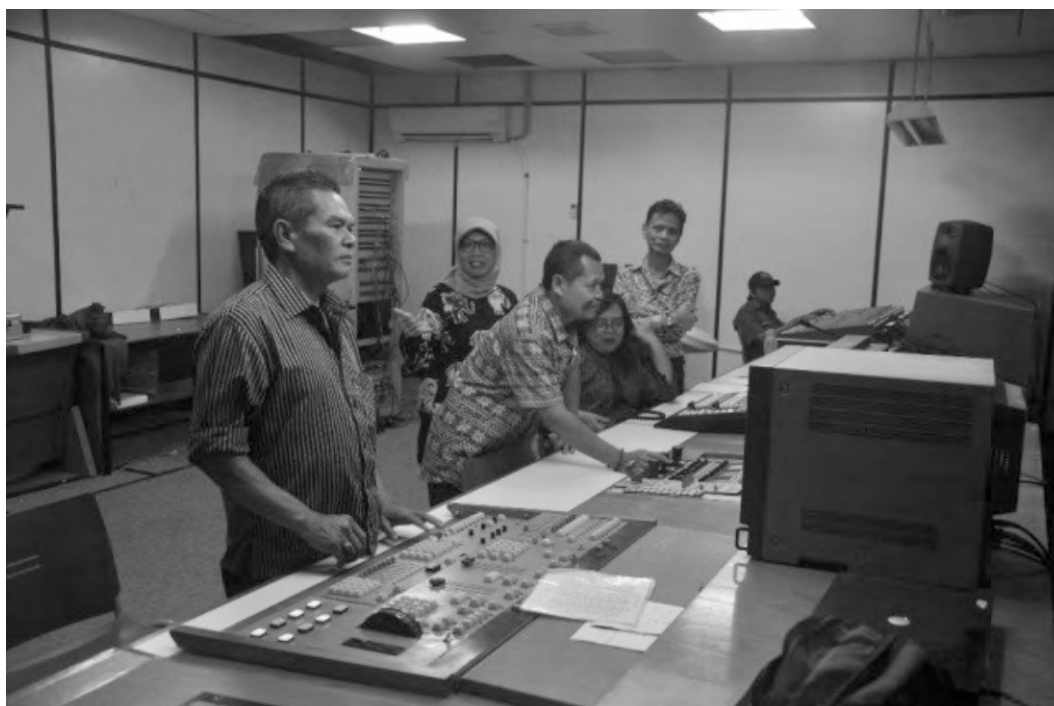
Gambar 2. Sub Control Room (Studio 1) TVRI Stasiun Jawa Barat
